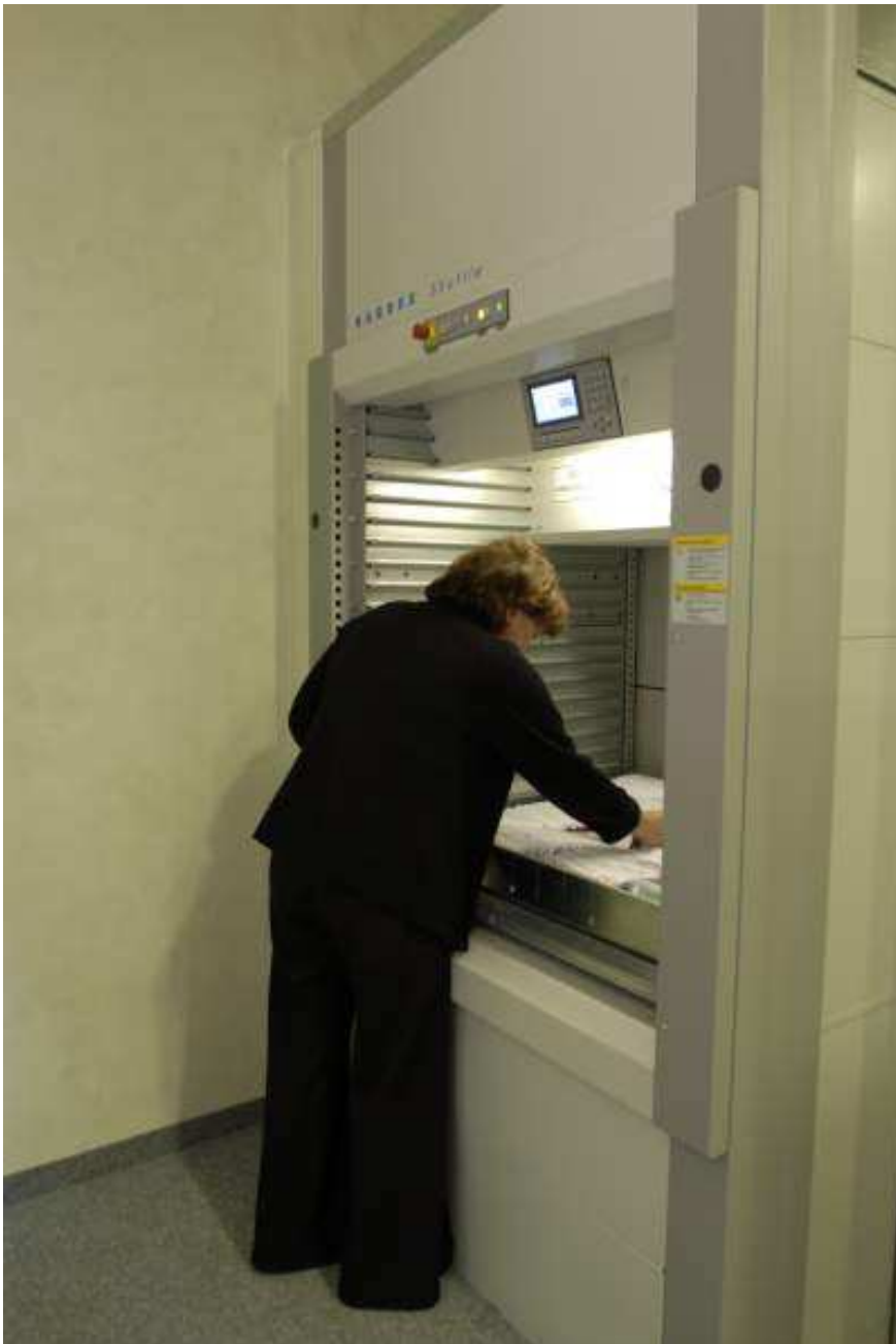
Agenda občanských průkazů a pasů ve výtahovém systému procházejícím přes 3 patra.
